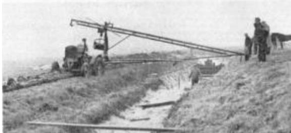
Abb. 1. Das Anhängelbrückengerät System „Dertin“ im Graben eine Spundwand, davor eine Person zum Einsetzen des Kübels.
